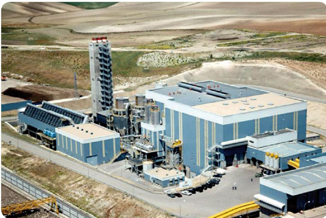
Planta de Tratamiento Integral de Residuos Sólidos Urbanos Tirmadrid.
