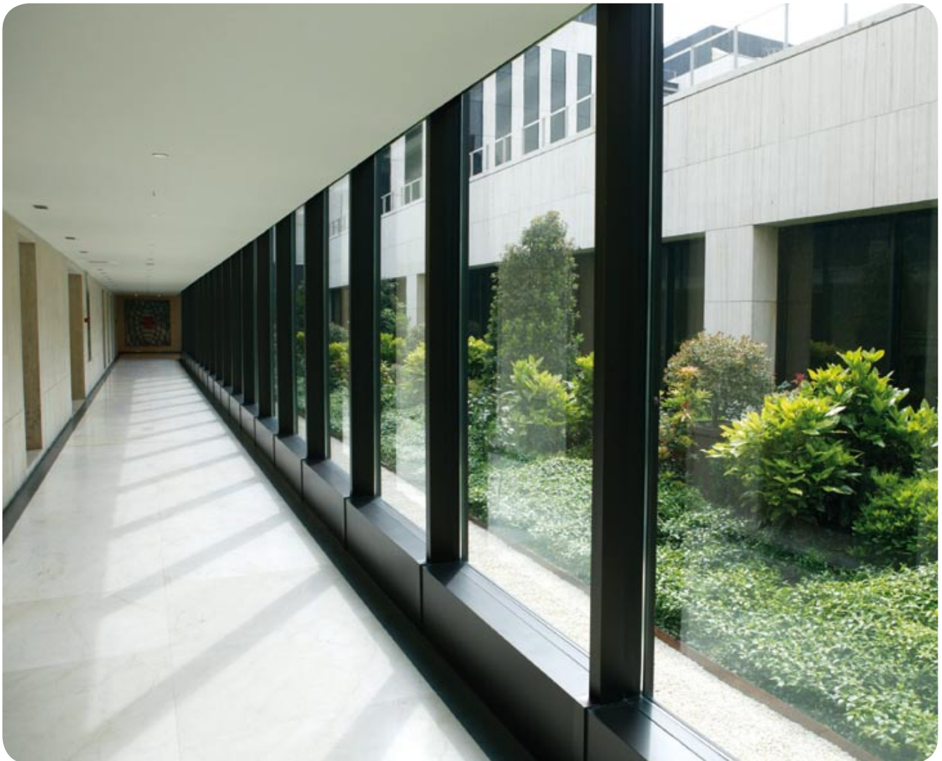
Pasillos con iluminación natural.
