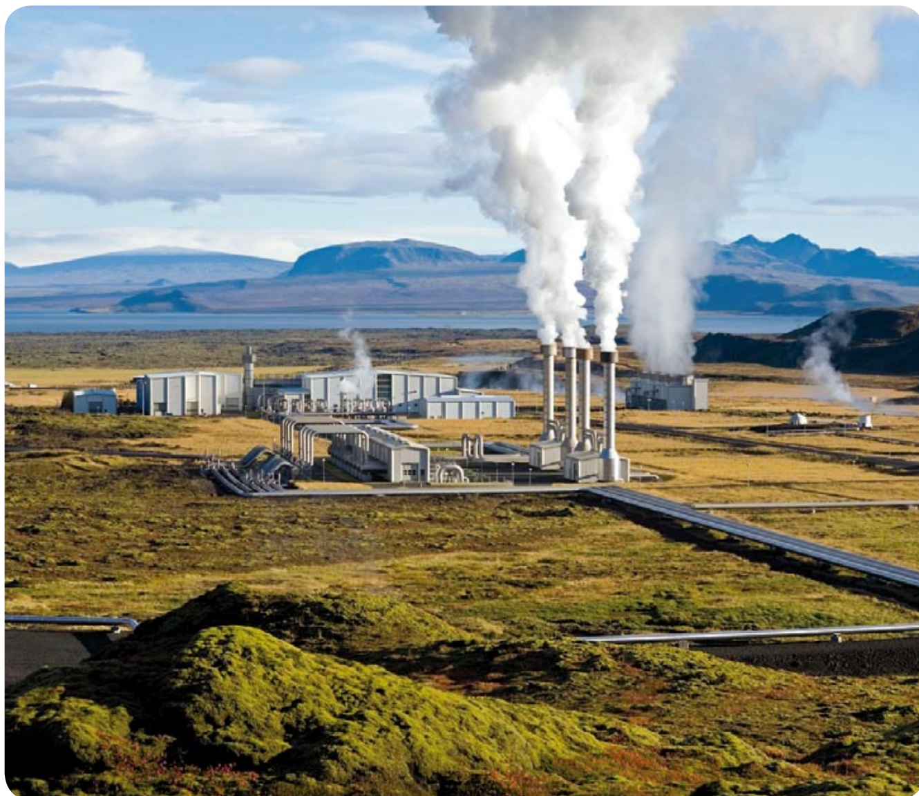
Planta Geotérmica de Nesjavellir en Islandia.
