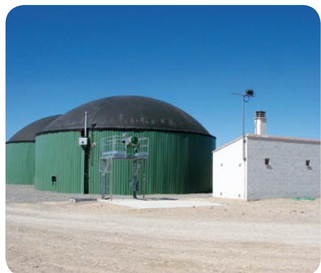
Planta de digestión anaerobia de purines de cerdo con mezcla de otros residuos orgánicos.
