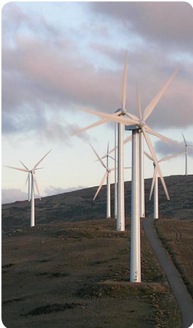
Parque Eólico de Aldeavieja (Ávila).
