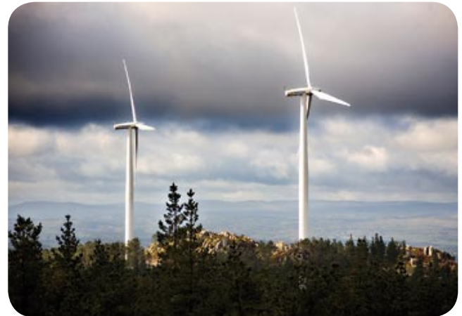
Aerogeneradores de eje horizontal.
