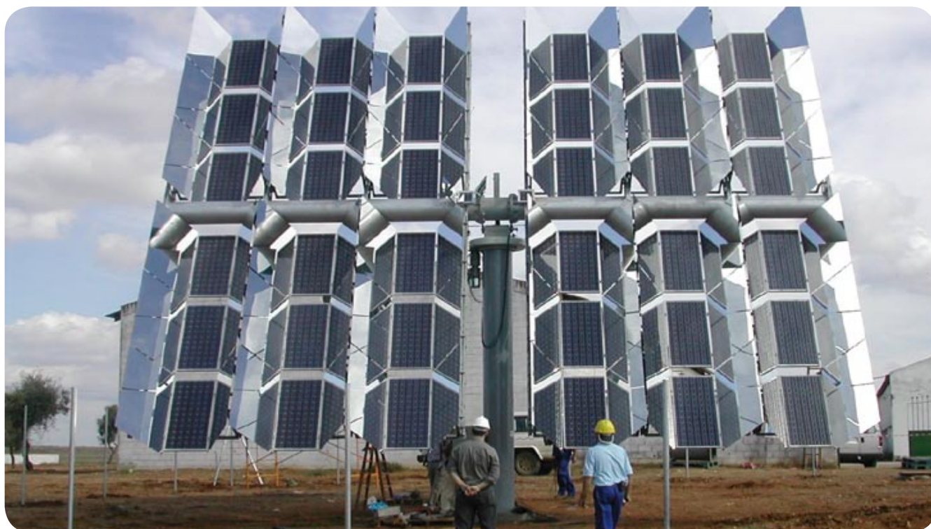
Módulos fotovoltaicos comerciales con concentración solar 2X en Sevilla PV. Plataforma Solúcar. Abengoa Solar.
