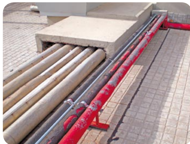
Aislamiento deteriorado.
