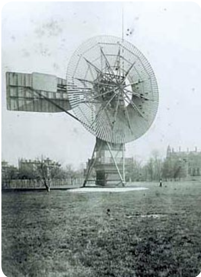
Primera turbina eólica para generación de electricidad construida por Charles Brush.
