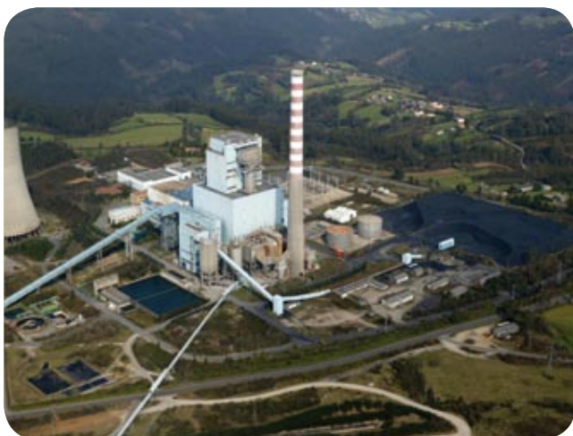
Central Térmica de Meirama (La Coruña).
